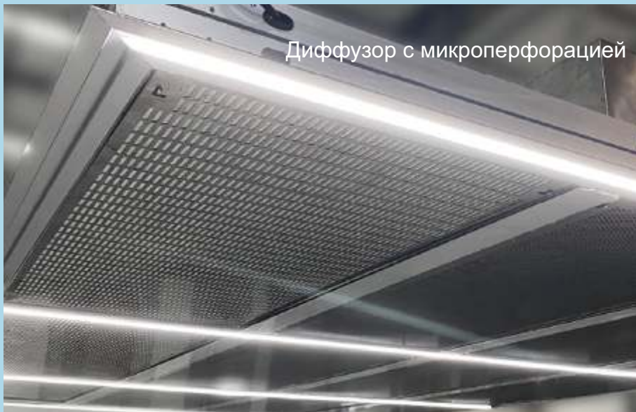
Пленка обеспечивающая ламинарный поток воздуха
