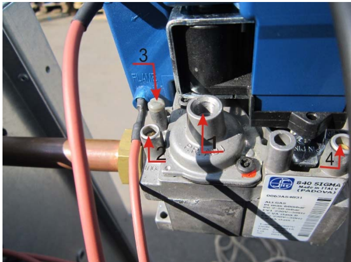
Позиция 1 – Серворегулятор давления. Позиция 2 – Штуцер для измерения выходного давления. Позиция 3 – Штуцер для компенсации давления в камере сгорания. Позиция 4 – Штуцер для измерения входного давления.
