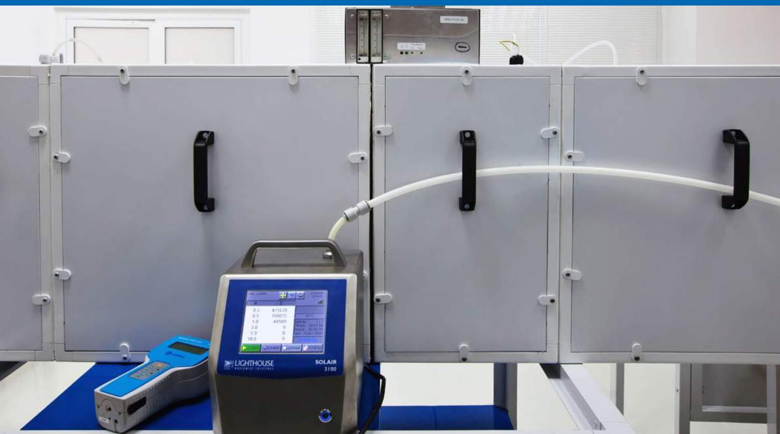
Установки обеззараживания и очистки предназначены для высокоэффективного обеззараживания и очистки воздуха в системах приточно-вытяжной вентиляции, в том числе в режиме рециркуляции.
