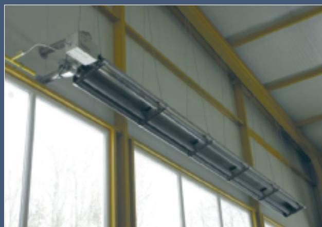
установка инфраизлучателя Helios
