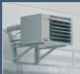
монтаж агрегата на стену
