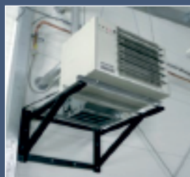
монтаж агрегата на стену
