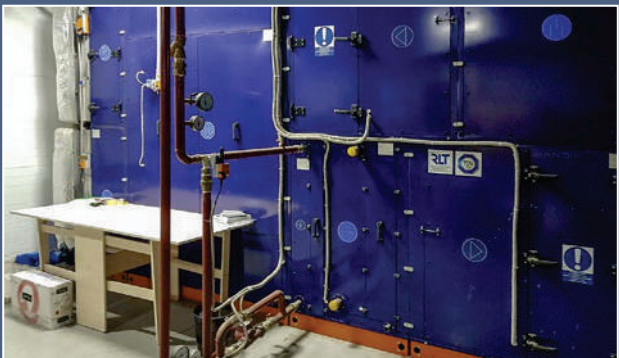
СП ЗАО «ЮНИСОН» - автомобильный завод Минский р-н Республика Беларусь - установка с пластичным рекуператором
