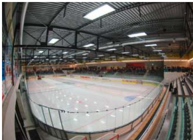
Ледовый каток „IWC Arena“, Шаффхаузен (Швейцария)
