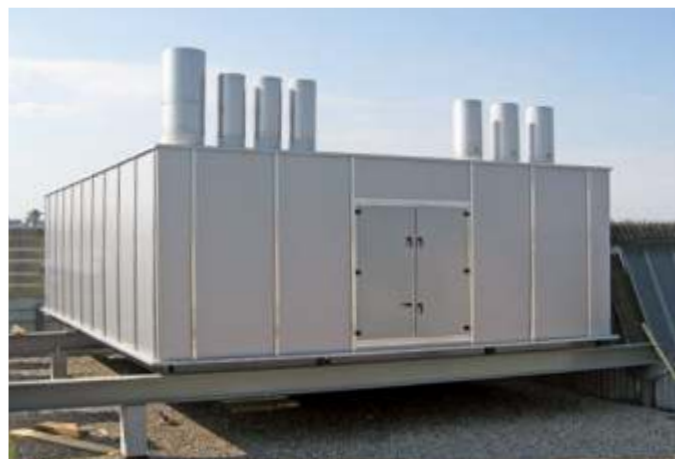
Объект „Flexcell VHF-Technologies SA“, Ивердон (Швейцария)
