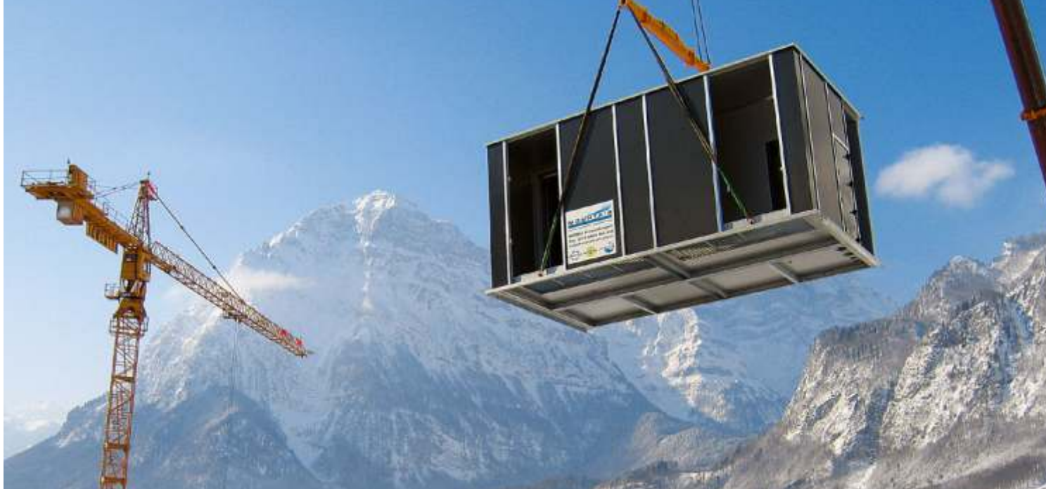
Монтаж Sauter Bachmann, Нетшталь
