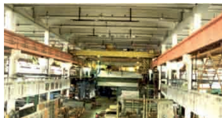
Краснопресненский з. ЖБК ДСК-1, г. Москва
